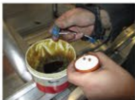
Grasa dieléctrica adicional agregada
